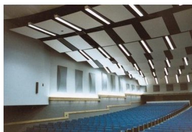
天井吊り下げクラウドの設置例
